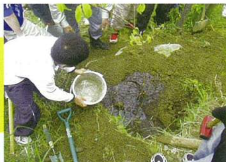
堤防を補強したあと、バケツ1杯分の水を入れます。洗んだ箇所を黒土で埋めてひとまず完成です。
