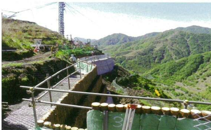
山腹工(基盤整備)の様子
